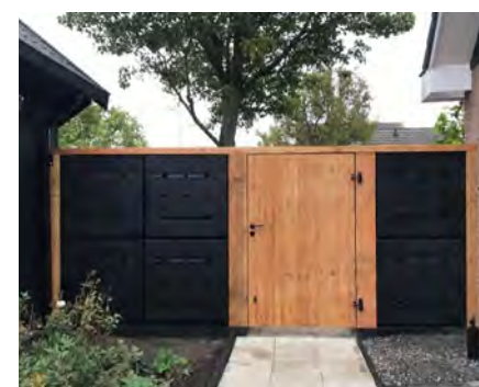
Regenwater wordt gebufferd in de toegangspoort
