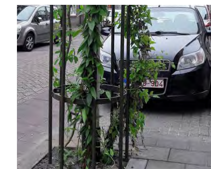
Klimplanten met stalen frame constructie rond een lichtmast
