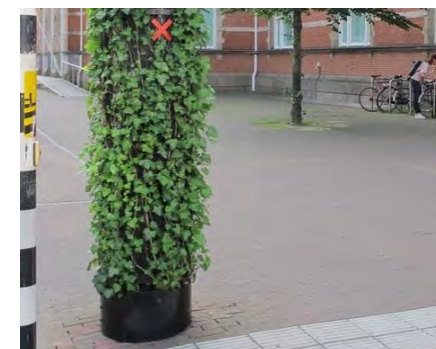
Klimplanten met stalen rooster constructie rond een lichtmast
