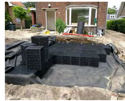
Waterbuffering en infiltratie door middel van infiltratiekratten
