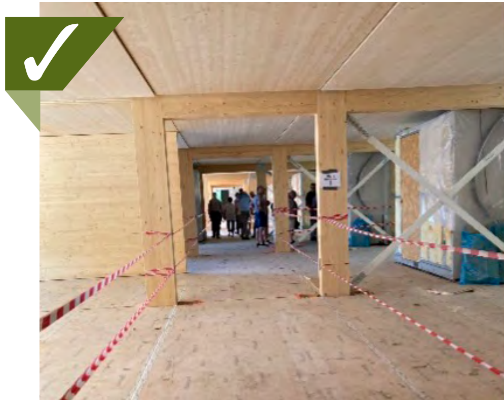
Houtbouw (FsC hout).
