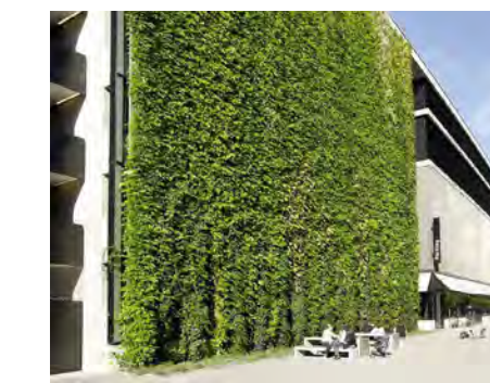
Hoge groene gevel, waar de klimplant wordt geleid door spandraden
