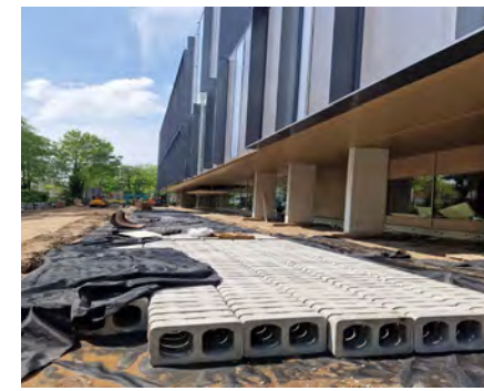
Waterbuffering en infiltratie met draagkrachtige betonelementen
