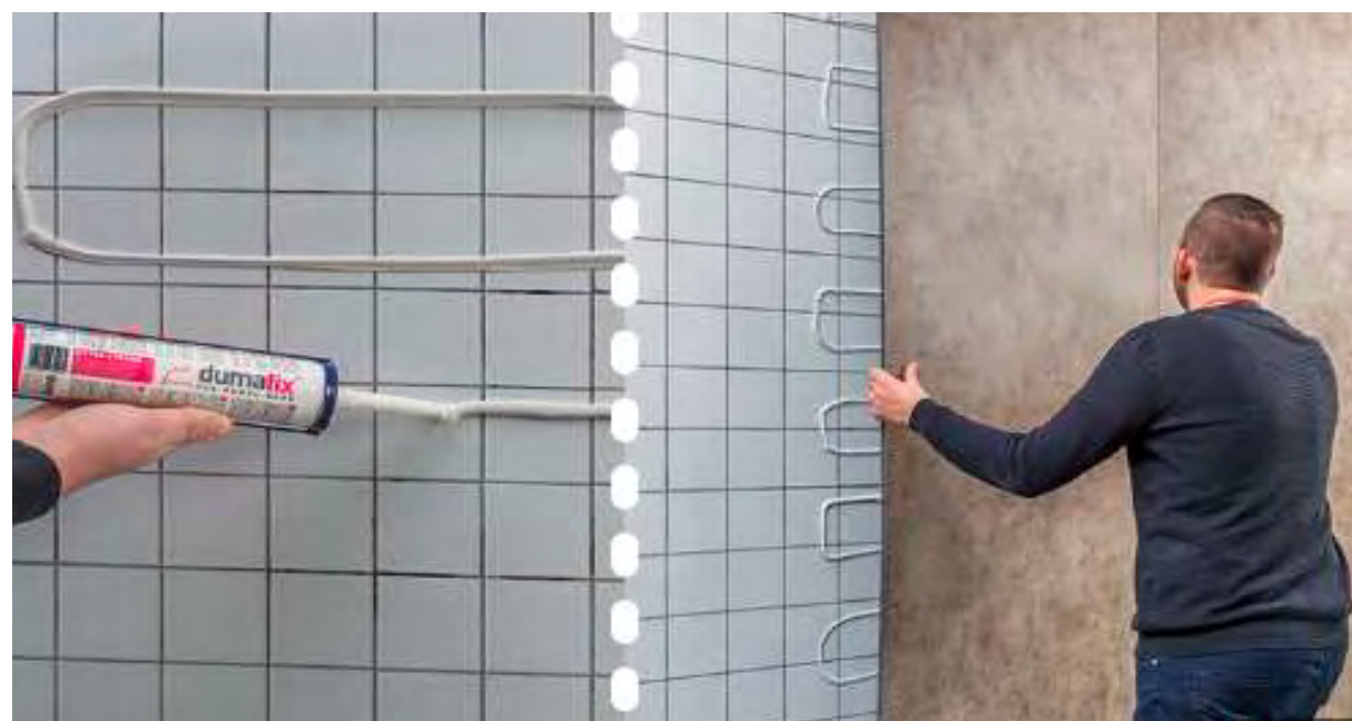
Aanbrengen wandpaneel
