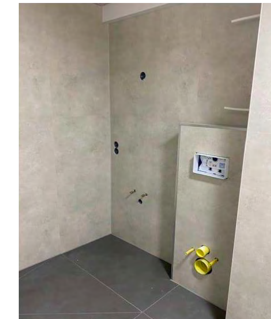
Vloer- en wandpanelen toilet
