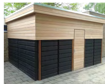
Hemelwater wordt gebufferd in de wanden van de schuur
